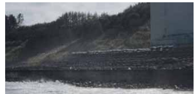
仮設防潮堤設置状況
