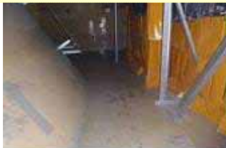
鋼製支柱設置前（5/31撮影）
