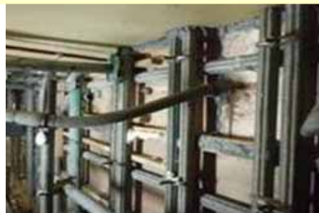
グラウト注入状況（7/30撮影）
