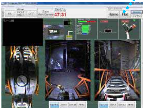
3号機原子炉建屋内の階段を上る様子 ※操作画面（7月26日）
