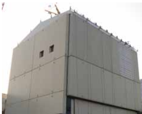
1号機原子炉建屋カバー設置
