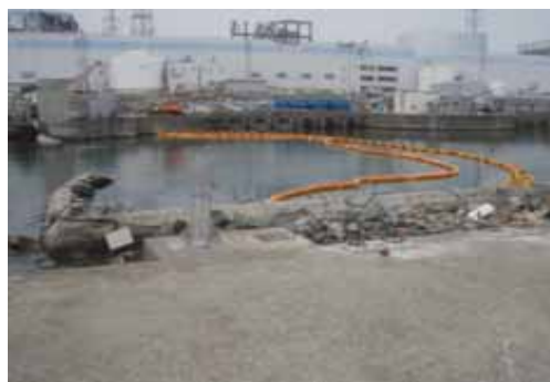
シルトフェンス設置
