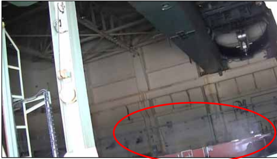
9月17日撮影の5階原子炉直上部からの蒸気放出
