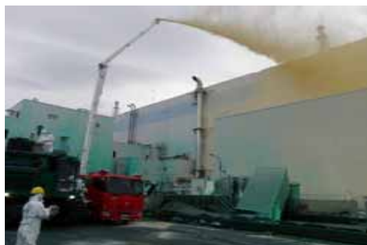
敷地、建屋本体への飛散防止剤散布
